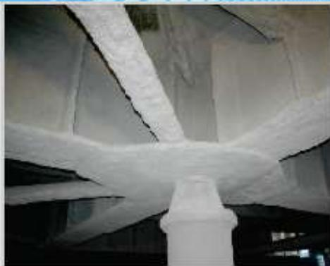
Состав для конструктивной огнезащиты «Монокот™- Крилак Z» представляет собой сухую смесь неорганического вяжущего с наполнителями и функциональными компонентами.
