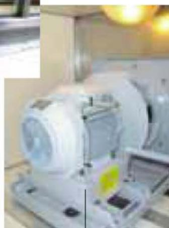
Вентиляторы с прямым приводом для упрощения процедуры очистки
